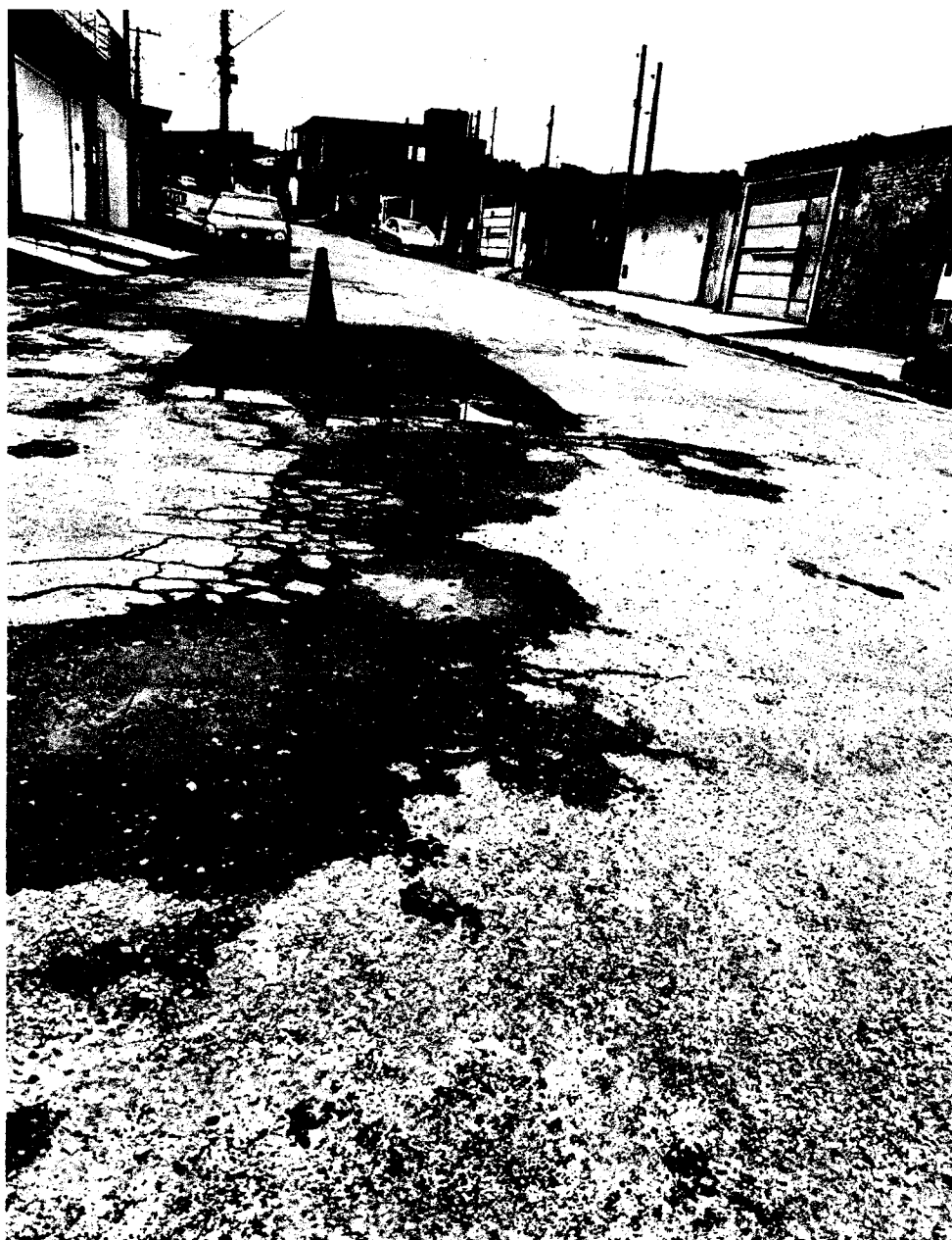
RECAPEAMENTO em toda extensão da Rua Darci Pereira, Jardim Planalto – Mogi das Cruzes.
